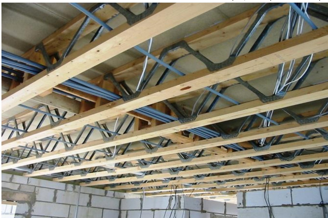
Obr. 42 Pohled ze spod, na stropní POSI nosníky
