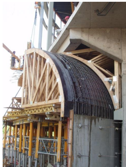
Obr. 27 Bednění sportovního stadionu
