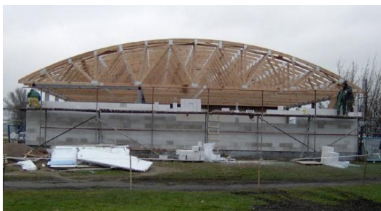
Obr. 33 Obloukové vazníky nad výrobní halou
