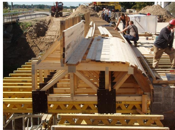
Obr. 25 Montáž ramenátů pro bednění mostu
