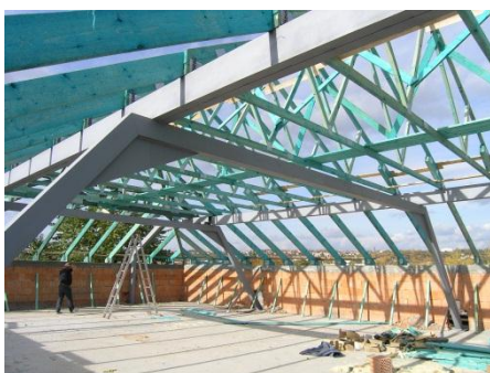
Obr. 37 Nástavba bytového domu
