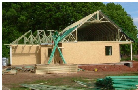
Obr. 28 Podkrovní vazníky na RD
