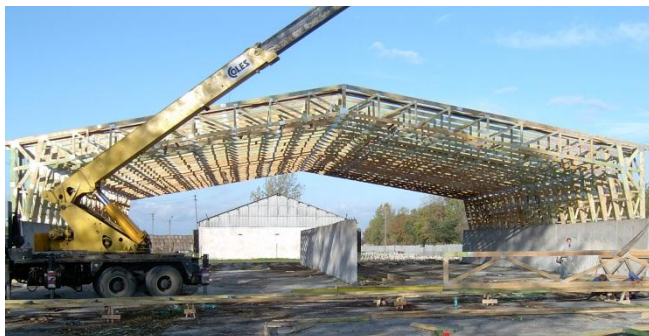
Obr. 34 Portálové vazníky nad silážní jámou
