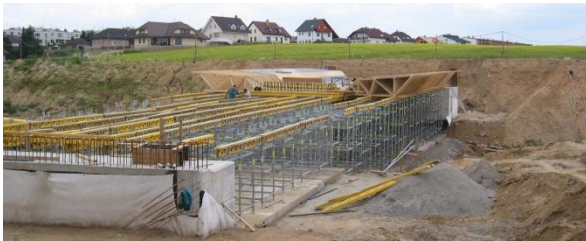
Obr. 24 Ramenáty pro bednění mostu
