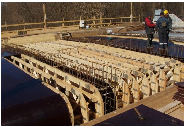
Obr. 26 Ramenáty pro bednění mostu
