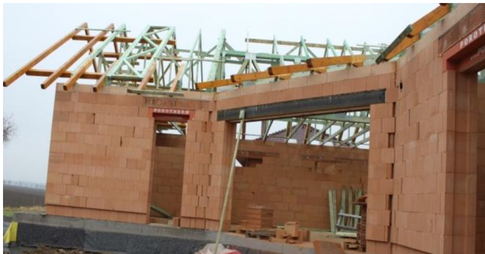
Obr. 10 Konstrukce vazníkové střechy s příznanými krokvi
