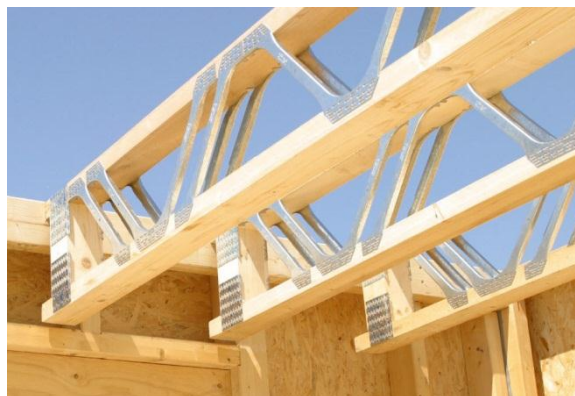
Obr. 40 Detail uložení stropních POSI nosníků
