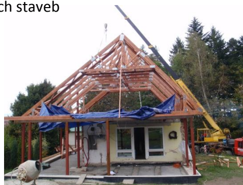
Obr. 29 Podkrovní vazníky na RD
