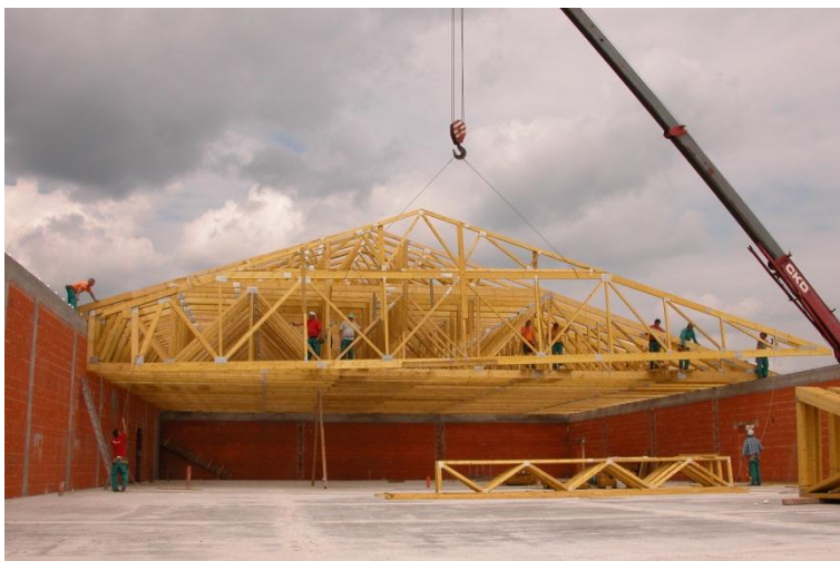
Obr. 36 Sedlové vazníky nad prodejní budovou
