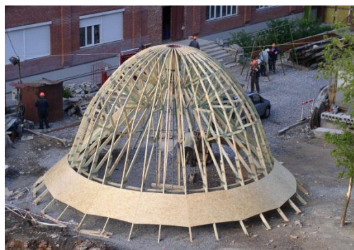
Obr. 8 Konstrukce věže kostela
