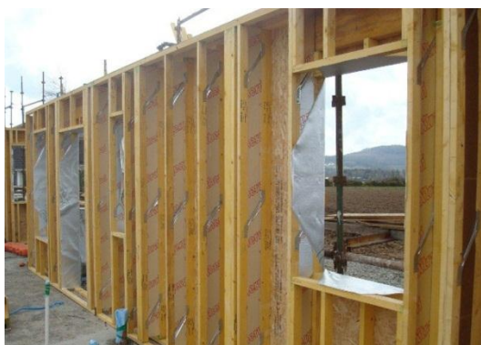
Obr. 44 Pohled na stěnu z POSI nosníků
