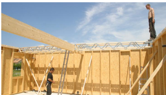
Obr. 45 Montáž stropních POSI nosníků
