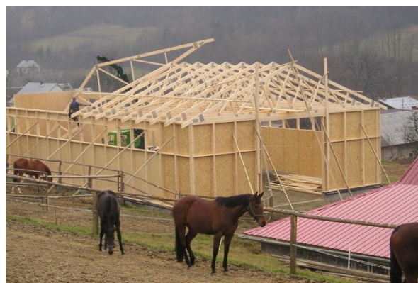
Obr. 20 Zastřešení stájí sedlovými vazníky
