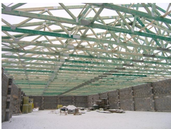
Obr. 11 Zastřešení výrobní haly sedlovými vazníky
