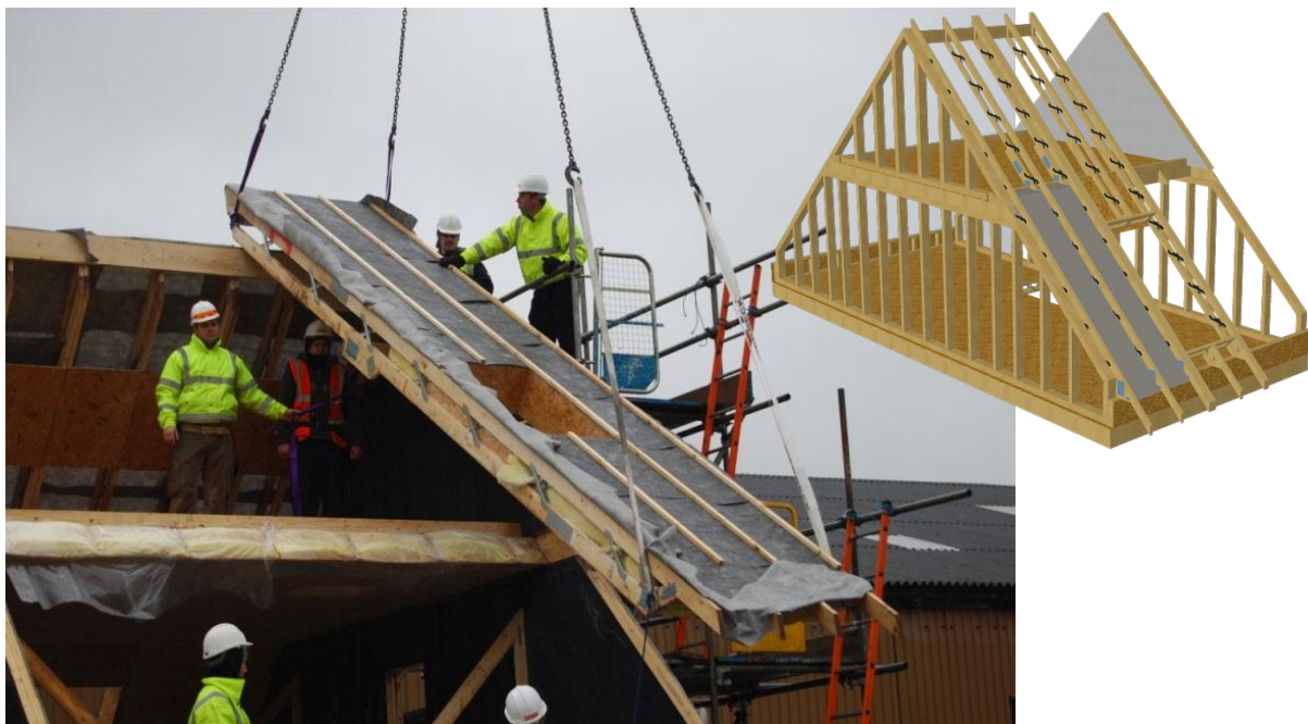
Obr. 46 Montáž střešních POSI nosníků
