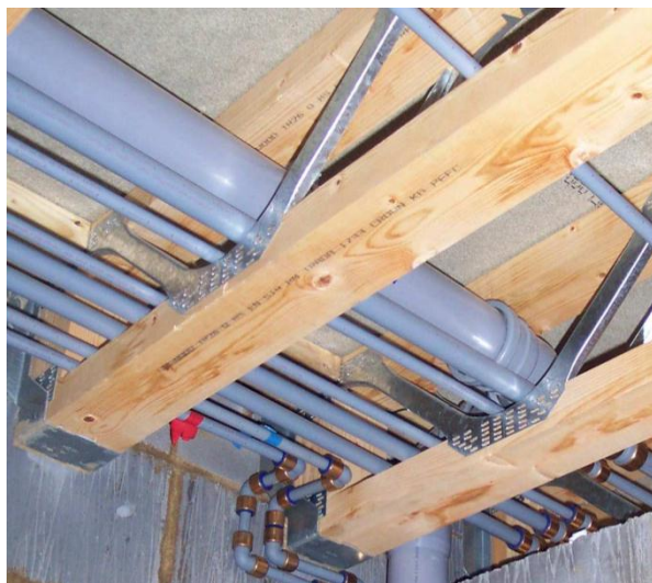
Obr. 43 Detail vedení rozvodů TZB
