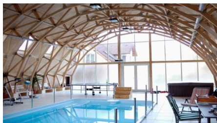
Obr. 39 Zastřešení rodinného bazénu
