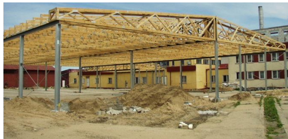
Obr. 18 Zastřešení výrobní haly obloukovými vazníky
