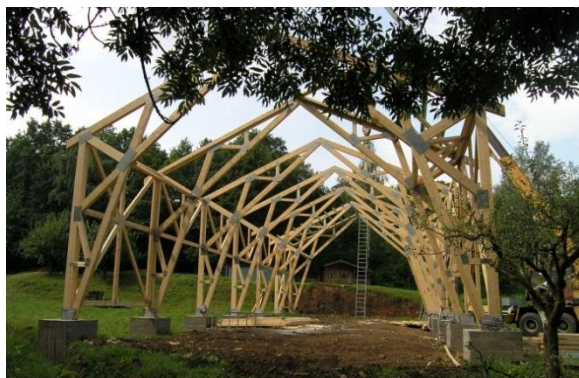
Obr. 13 Portálová konstrukce seníku
