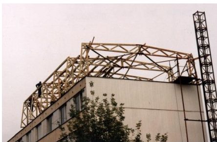
Obr. 35 Nástavba panelového domu
