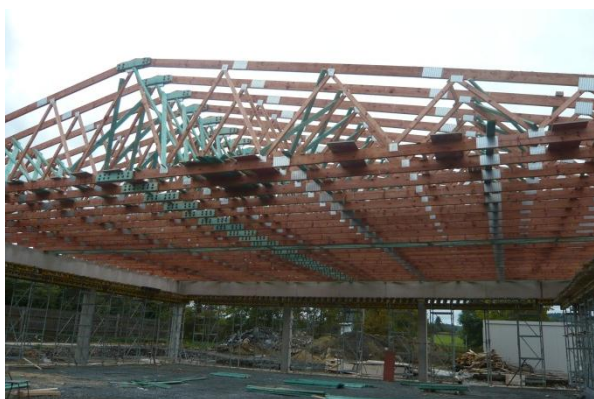
Obr. 19 Zastřešení haly sedlovými vazníky
