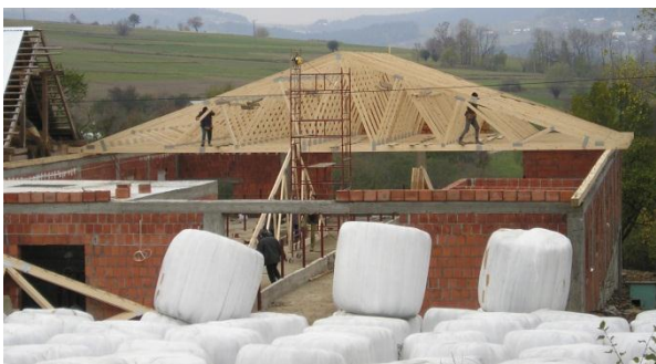
Obr. 21 Zastřešení výrobní haly sedlovými vazníky
