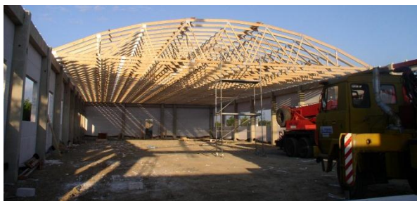
Obr. 17 Zastřešení haly na ocelové konstrukci
