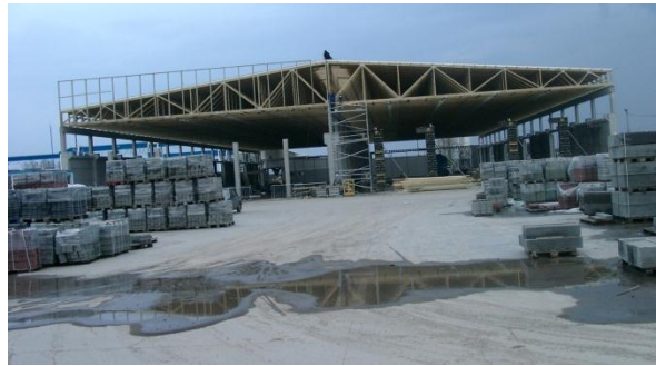
Obr. 22 Zastřešení skladovací haly sedlovými vazníky
