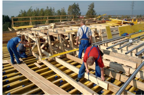
Obr. 23 Montáž ramenátů pro bednění mostu
