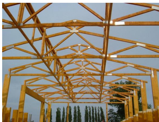
Obr. 9 Konstrukce skladu soli
