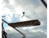
Le gain de temps proposé par les caissons est principalement dépendant de la préparation du site avant installation. En effet, les murs et poutres support ainsi que l'entretoisement temporaire doivent être en place avant l'arrivée des caissons sur le chantier. Finir l'installation pendant la mise en place des caissons amène à un rallongement coûteux de la durée de pose.
