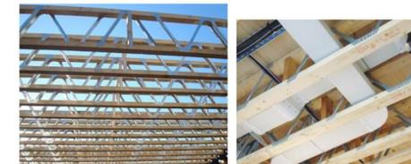
Son avantage majeur est la grande facilité d'installation pour toutes les gaines de ventilation, canalisations ou évacuation. Aucun perçage, aucune zone d'affaiblissement, elle permet un travail propre et rapide, bien plus simple qu'avec des poutres en I ou massives.
